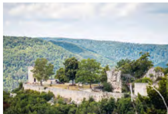
Burg ruine Helfenstein
